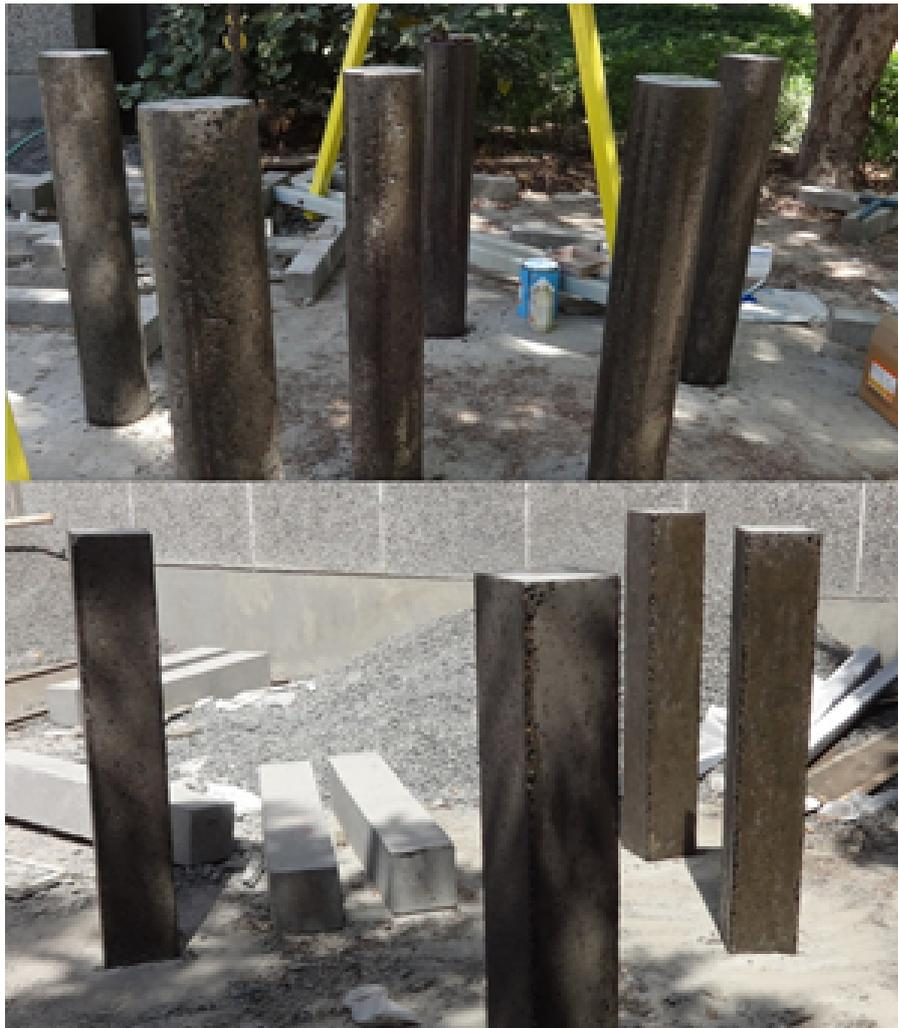
Figure 3.22: Primer Coat on Columns
