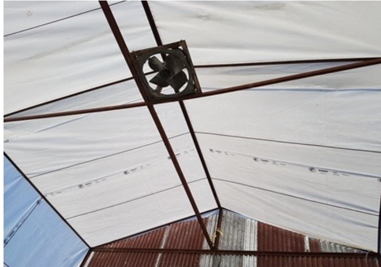
Figure 4.8: Fan System (VAF)
